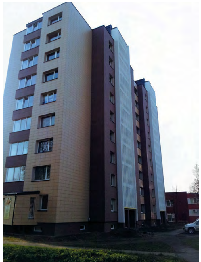
Joonis 2. Keraamiliste plaatidega renoveeritud fassaad.
