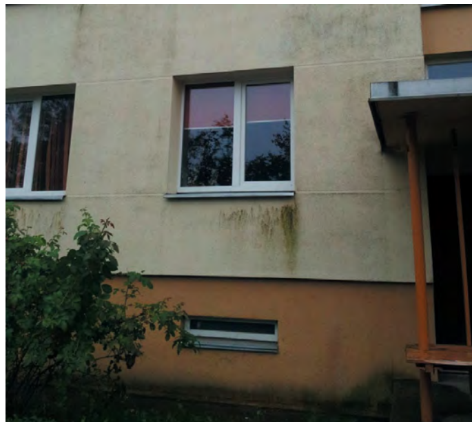
Joonis 1. Struktuurkrohvi on raske kõrvaldada graffitit, samuti on näha veekahjustused.
